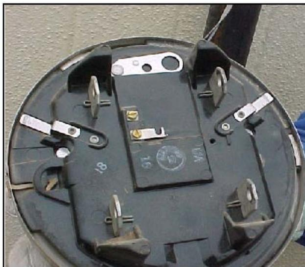
**FIGURA 3.2: MEDIDOR CON PUENTE DE BOBINA ABIERTO.**
