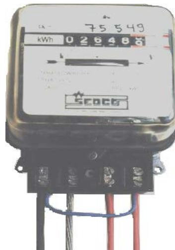
**FIGURA 3.1: MEDIDOR CON BORNERAS PUENTEADAS.**
