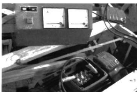
FIGURA 5.22. Medición de la Rigidez dieléctrica del bobinado.
