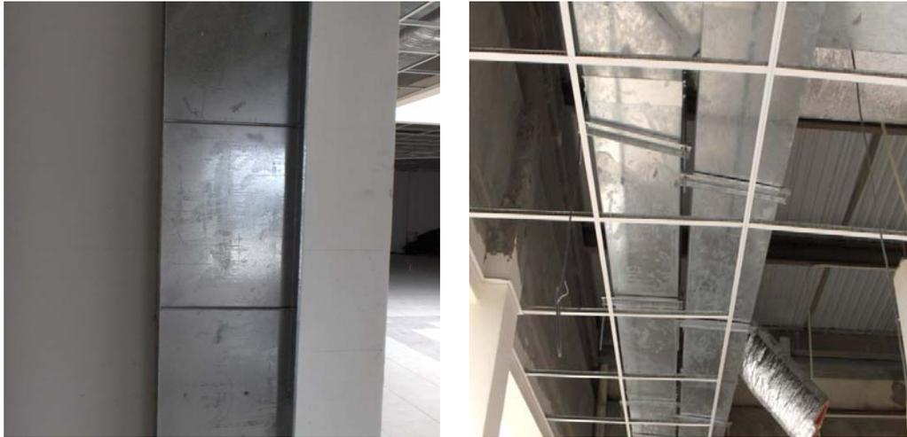
FIGURA 2.10 CANALETA PARA CABLES DE DATOS
