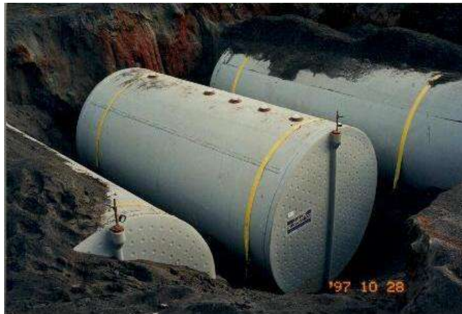
Figura 4.6 Tanques de almacenamiento
