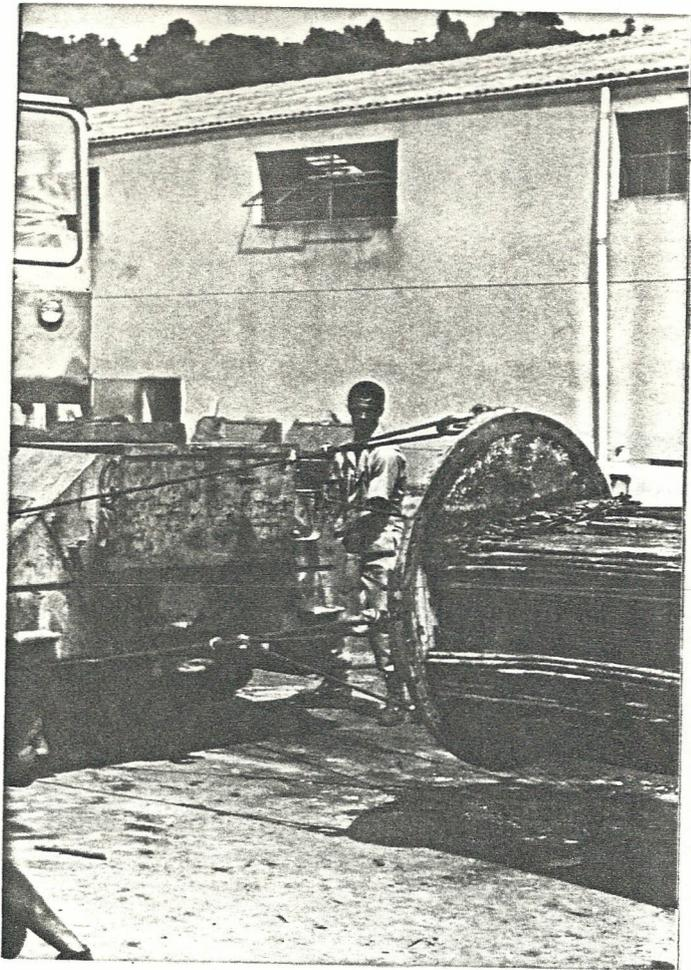
FOTO N° 3.2.- Sujección de espejo en 4 apoyos que servirían para retirar el haz de tubos.
