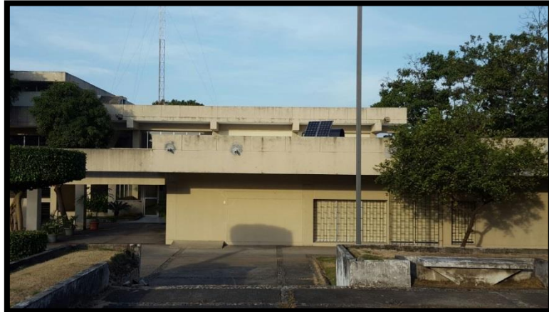
Figura 3.24: Instalación de los paneles fotovoltaicos
