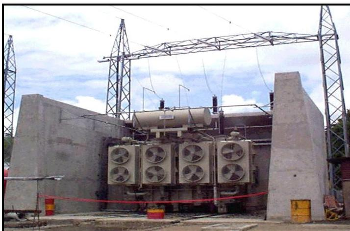
**Subestación.-** La Subestación está ubicada sobre un terraplén construido junto a la Central en la cota 42 msnm. El esquema adoptado para esta Subestación es 8 posiciones de interrupción en arreglo de doble barra con un solo disyuntor y 5 seccionadores, sirviendo uno de estos como by-pass, excepto en el caso de generadores y acoples de barras que emplean solamente dos seccionadores.
