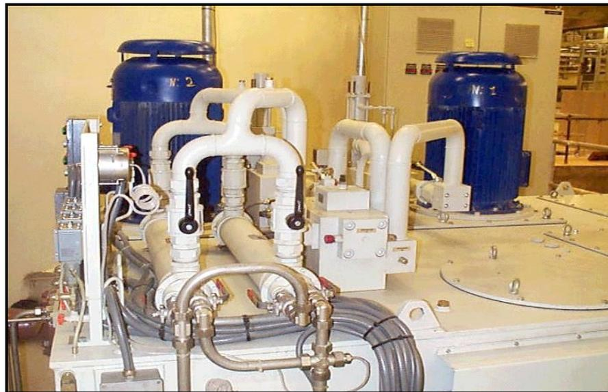
El Acumulador de Energía es alimentado por 2 bombas que están en un Reservorio de aceite y envían el mismo al acumulador pasando a través de una válvula de retención, la misma que funciona de la siguiente manera:
