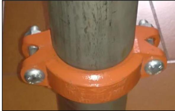
**Figura 2.33 Junta Tipo Acople Rígido**
