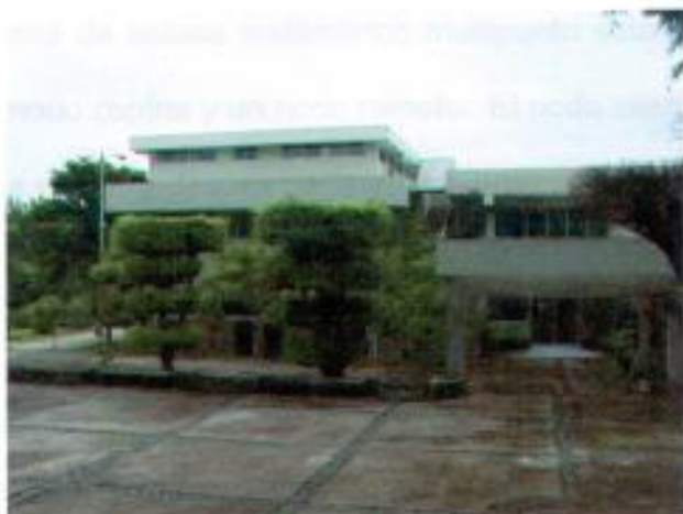
Gráfico 3-7 Edificio 37 en el área de tecnologías
