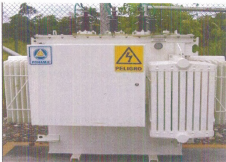
FIGURA 2.26 Transformador Reductor.
