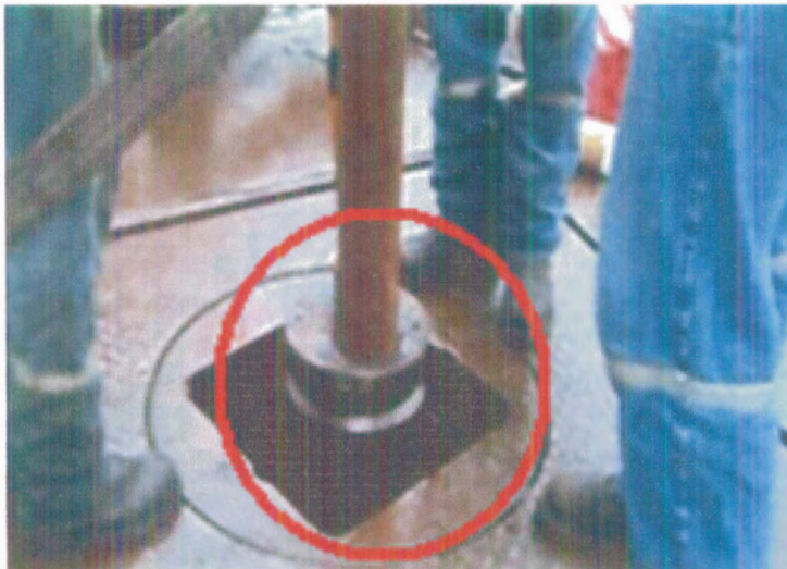
FIGURA 3.17 Bajada del "Tubing Hanger"
