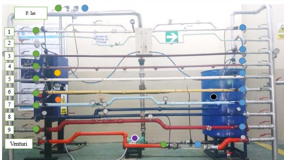
Figura 4-5 Estado actual de la planta de pérdida de presión
