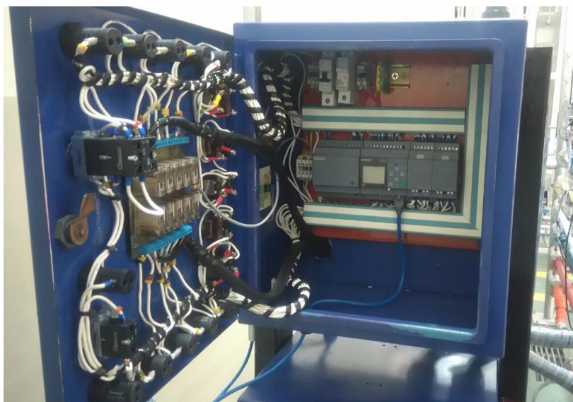
Figura 4-7 Vista general del interior del tablero
