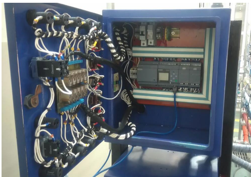
Figura 3-10 Vista general del interior del tablero
