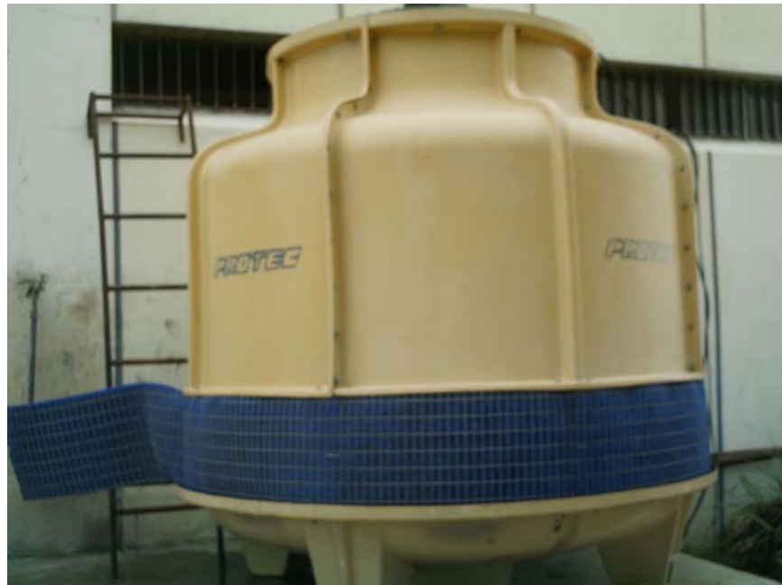
FIGURA 3.2. TORRE COMPLETA CON ESCALERA DESMONTABLE.
