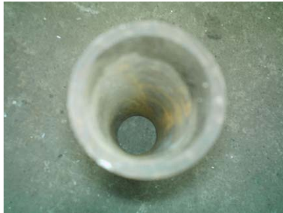
FIGURA 3.6. TUBERÍA DESPUÉS DE LA LIMPIEZA QUÍMICA.
