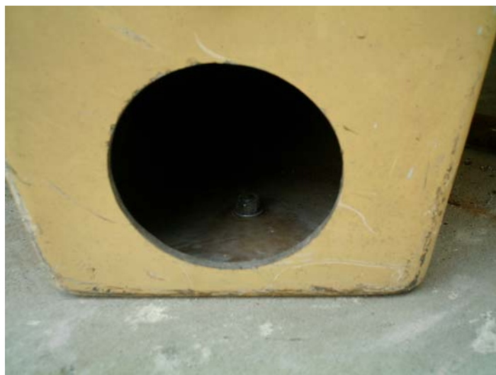
FIGURA 3.9. PERNO DE EXPANSIÓN COLOCADO PARA ANCLAR LA TORRE
