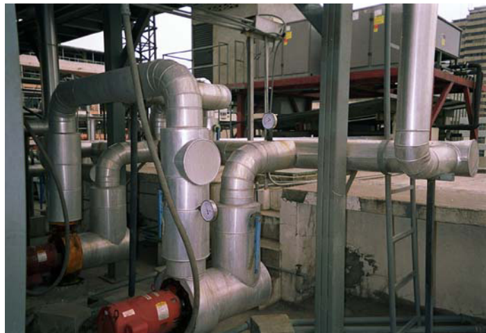
FIGURA 2.7 CIRCUITO SECUNDARIO DE BOMBAS
