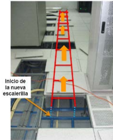
FIGURA 4-11 CABLE DE ENERGIA RECORRIDO HORIZONTAL (2)
