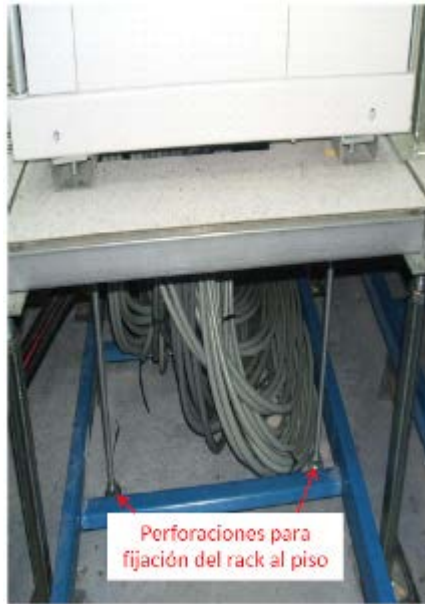
FIGURA 4-8 FIJACIÓN RACK
