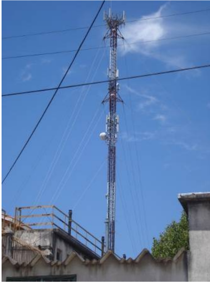
FIGURA 3-7 CONSTRUCCIÓN DE ELEVADA ALTURA
