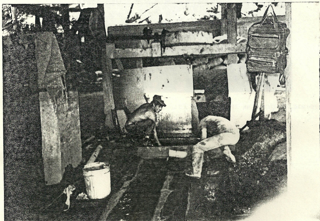
Fig. 16.- Molino Chileno y sistema de descarga.
