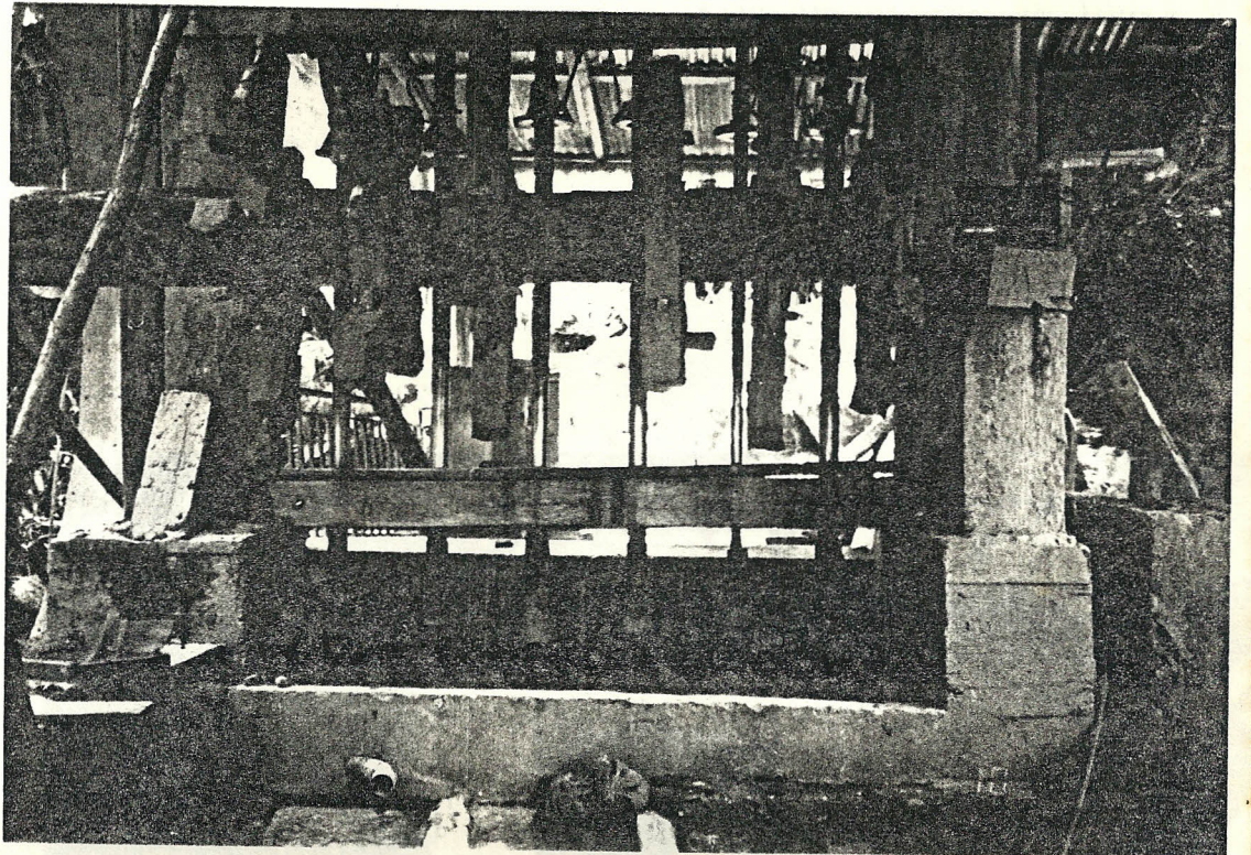
Fig. 3.- Molino de 6 pizones, movido por energía hidráulica.
