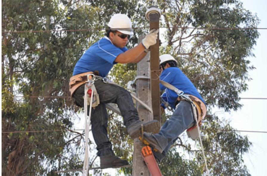
Figura # 5.5 Control de trabajos sin tensión
