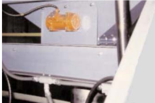
FIGURA3.17.- INSTALACIÓN DE VIBRADOR A LA SALIDA DE UNA TOLVA
