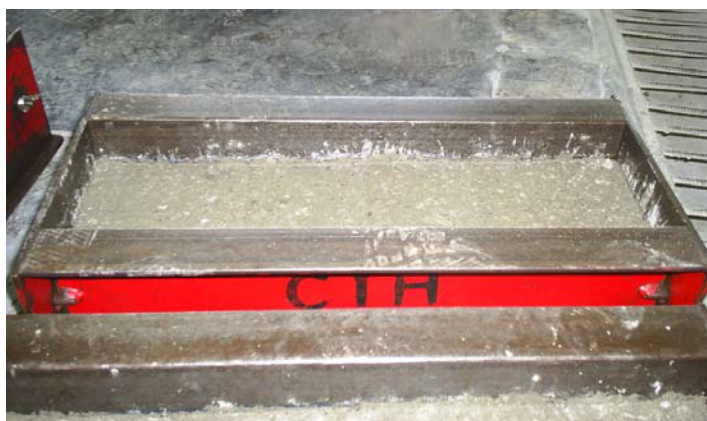
FIGURA 3.28 Procedimiento de llenado de vigas
