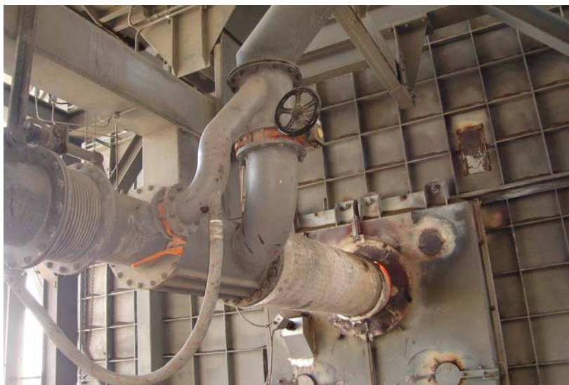
FIGURA 2.7: QUEMADORES PRINCIPALES
