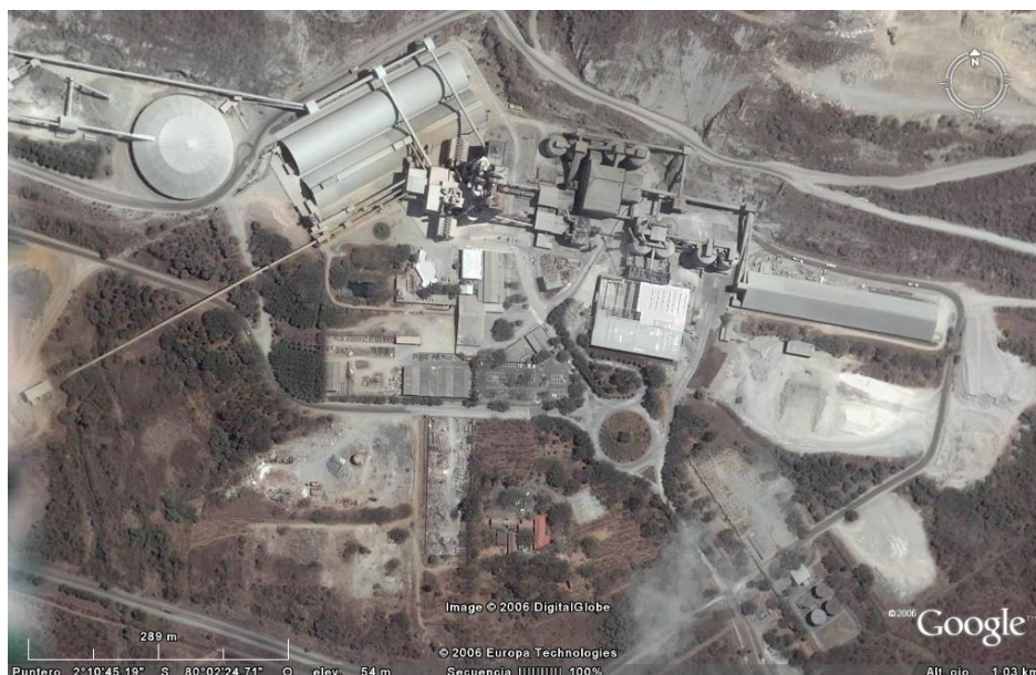
FIGURA 1.1: VISTA GENERAL DE LA PLANTA
