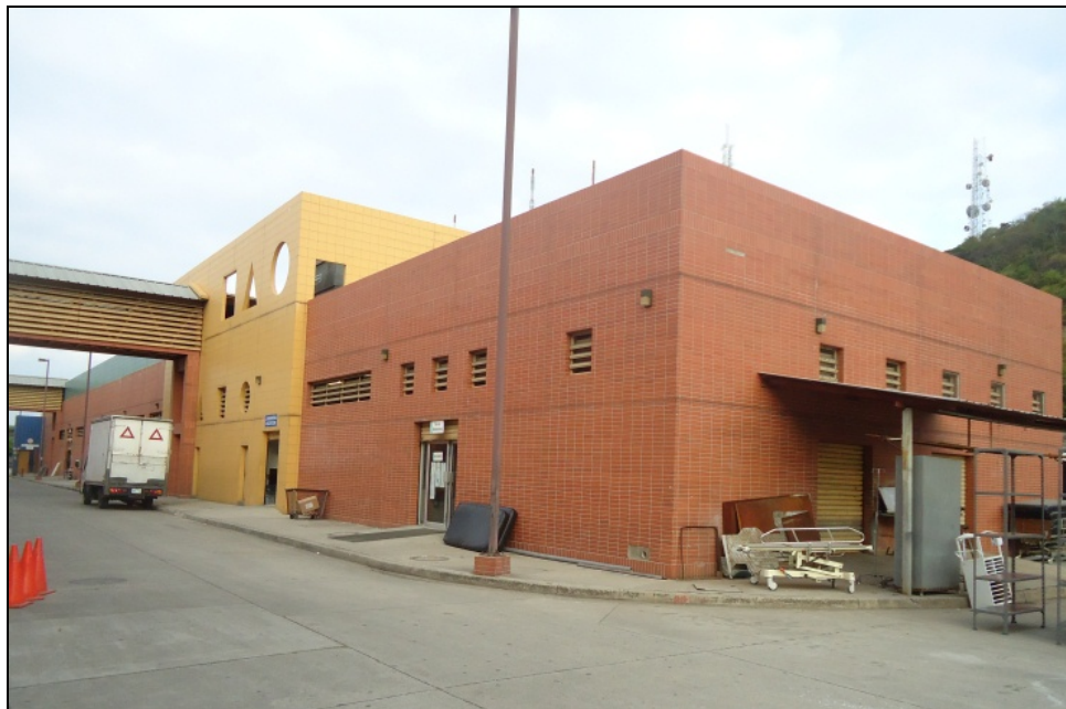
Figura 1.1 Casa de Máquinas Hospital “Roberto Gilbert Elizalde”
