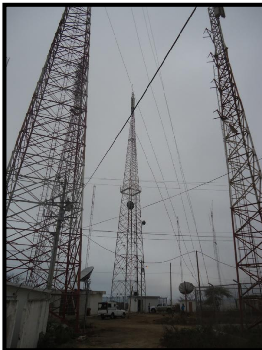
Figura 5.21 Antena Transmisor – Santa Elena
