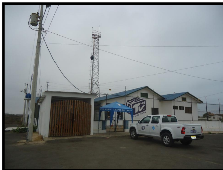
Figura 5.3 Instalaciones ESPOL TV - Ancón
