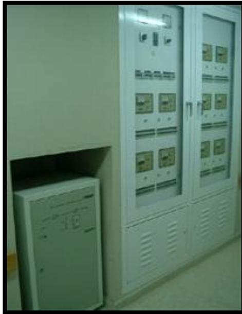
Figura 2.3.- Panel de detección de interrupción de la toma a tierra.
