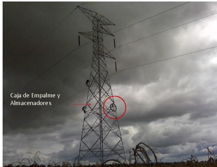
Figura 2.8.- Tendido de fibra óptica ADSS
