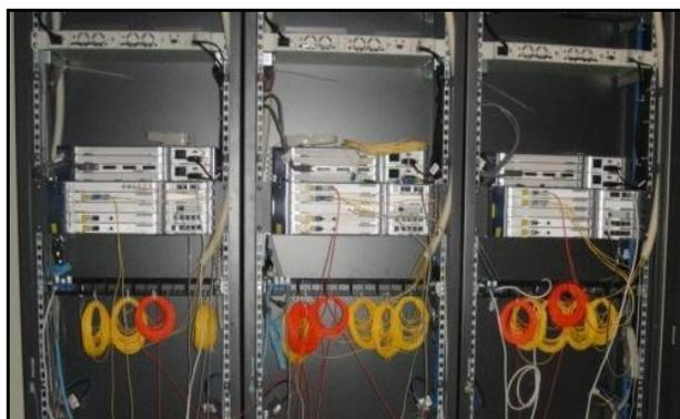
Figura 2.2.- Equipos HUAWEI OPTIX OSN1500 <sup>[9]</sup>
