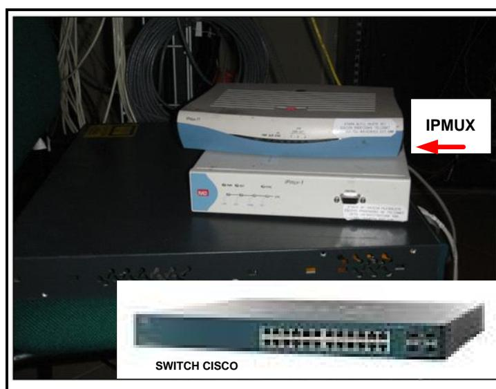
Figura 2.6.- IPMUX RAD – SWITCH CISCO <sup>[9]</sup>
