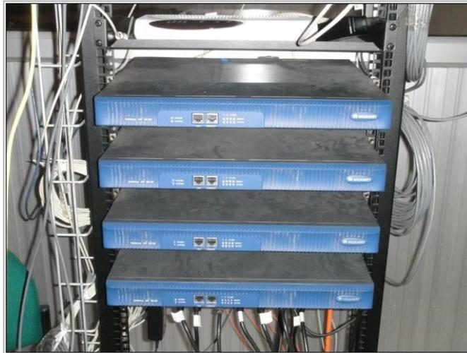
Figura 4.26.- Router HUAWEI QUIDWAY AR 28-30 <sup>[9]</sup>
