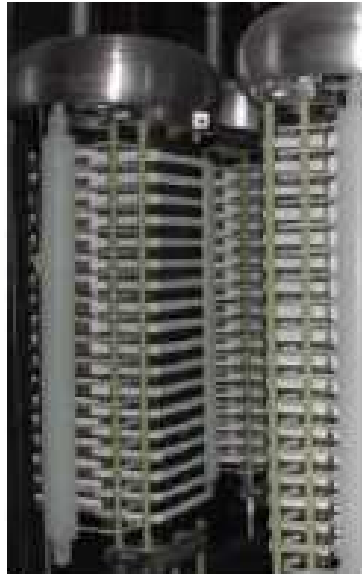
Fig. 3.4 Celda de IGBT's de un sistema HVDC [23].
