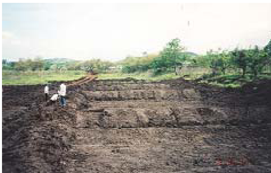
Módulos de cultivo recién construidos
