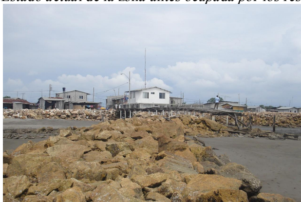
Foto 21 Estado actual de la zona antes ocupada por los restaurantes
