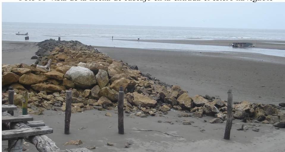
Foto 16 Vista de la flecha de cascajo en la entrada el estero navegable
