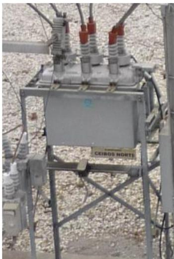
Fig. 11.1 Reconectador- Alimentadora Ceibos Norte
