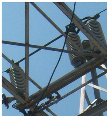
Fig. 4.1 Seccionador de Aire con cuchillas de Tierra
