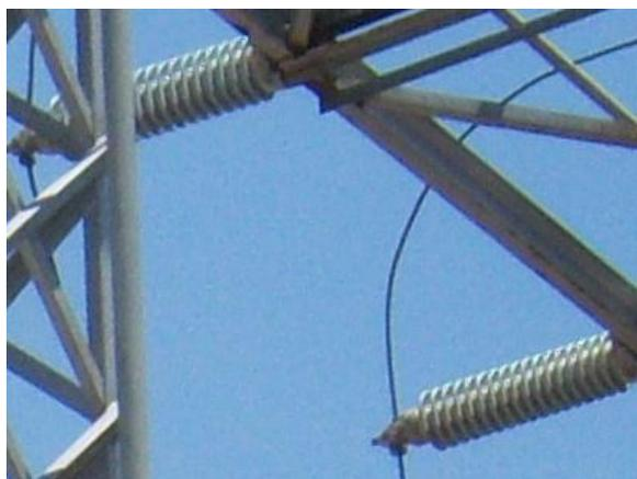
Fig.7.1 Pararrayos en estructura 69KV
