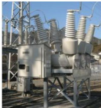
Fig. 5.1 Interruptor en Gas SF<sub>6</sub>
