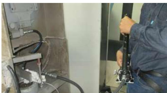
**Figura 2.3 Uso de bomba manual para llenado de sistema con aceite hidráulico.**
