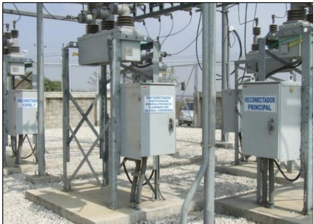
**Figura 1-10** Reconectores instalados en la Subestación ESPOL.
