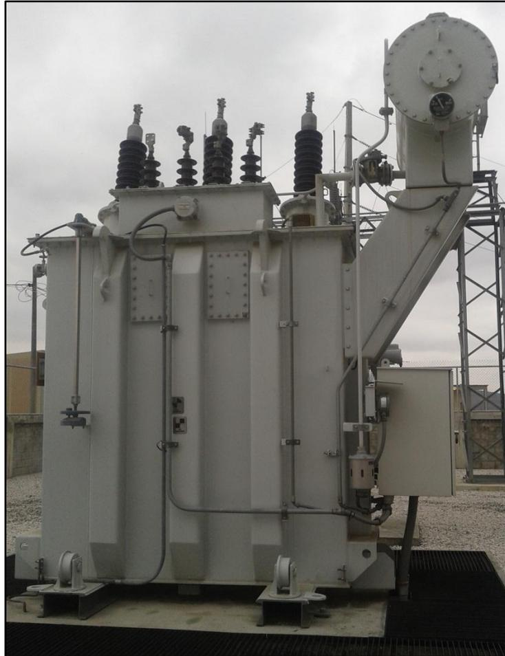
**Figura 1-7** Transformador de Potencia 10 / 12,5 MVA - ABB
