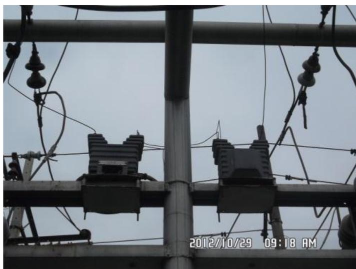
Figura 1.6 Transformadores de Potencial
