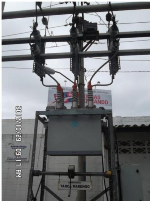
Figura 1.4 Estructura de Seccionadores de la alimentadora Tanca Marengo
