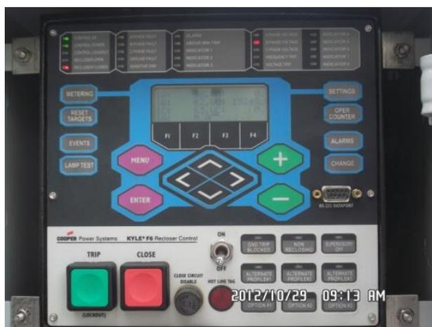
Figura 1.5 Panel de Controles de las Alimentadoras
