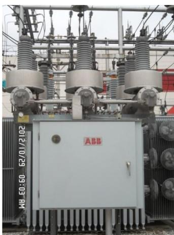
Figura 1.2 Unidad de Medición de Tensión y Corriente
