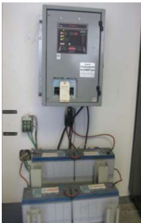
Figura 1.12 Cargador GNB y baterías Bosch.
