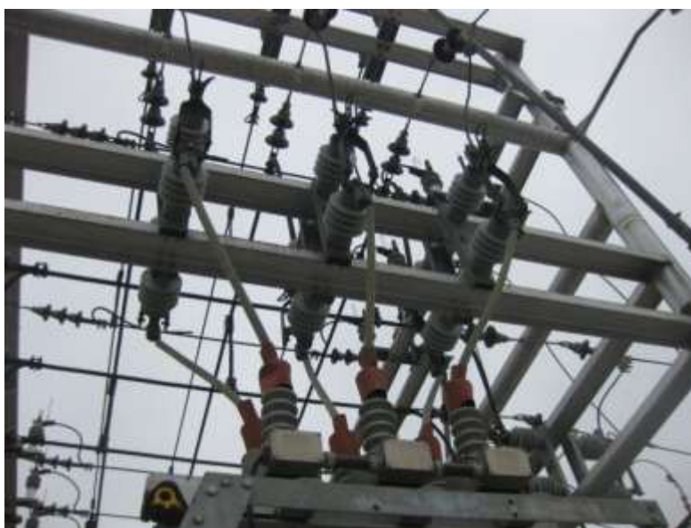
Figura 1.10 Cuchillas seccionadoras 600 A.
