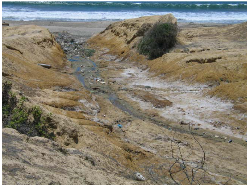
Descarga de efluentes
