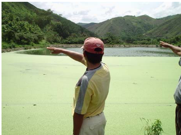
Foto N° 2: Laguna de Oxidación Cda. La Florida Fuente: Municipio de Portovelo
