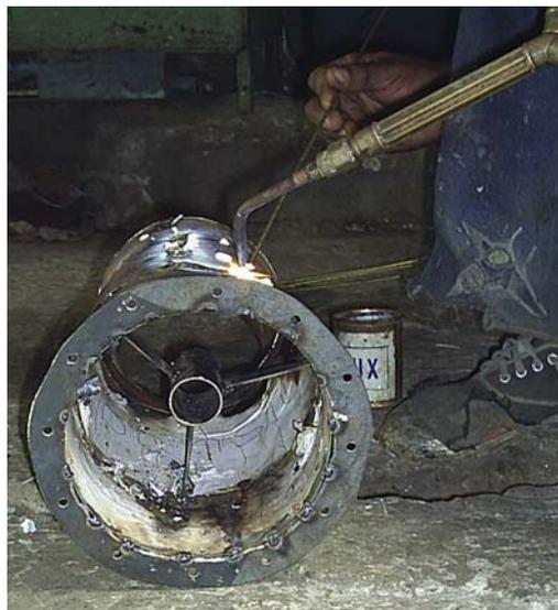
Figura 3.10.- Proceso de unión de las secciones del sistema de ducto.
