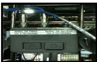
Figura 4.16. Splitter de canal local
