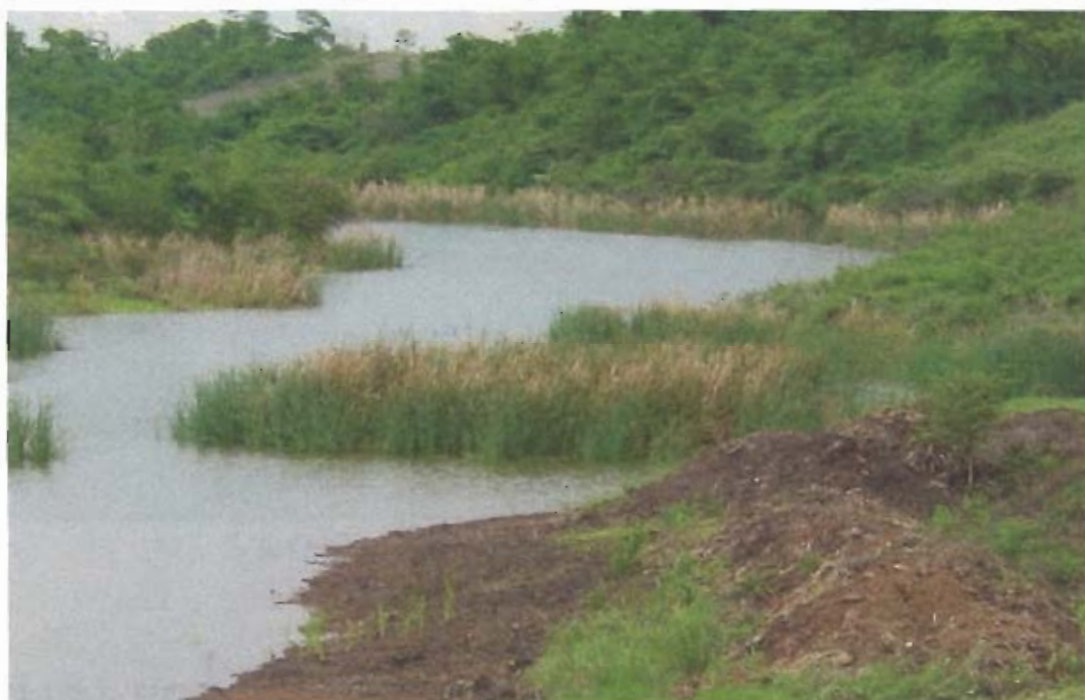
Foto 6. Lago de ESPO. época invernal, muestra del dragado de la cola del lago para retirar el exceso de sedimento del lago
