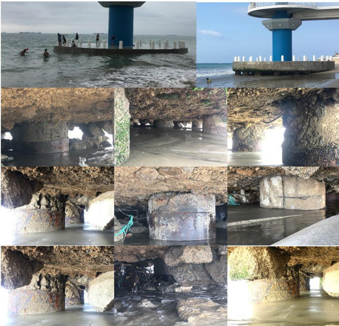
**Ilustración 57.- Fotos de afectaciones en la base del Mirador**
