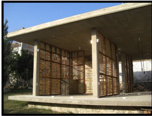
Figura 1-2 Paredes de Caña Guadua entrelazados, Guadalajara, México
