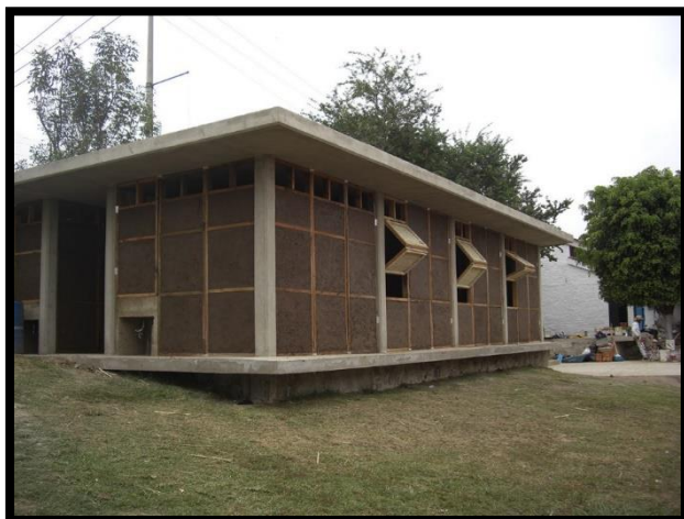
Figura 1-3 Paredes de caña guadua entrelazados recubiertas de barro, Guadalajara, México
