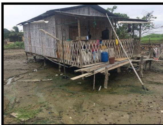
Figura 1-4 Vivienda de caña, Recinto La Unión.
