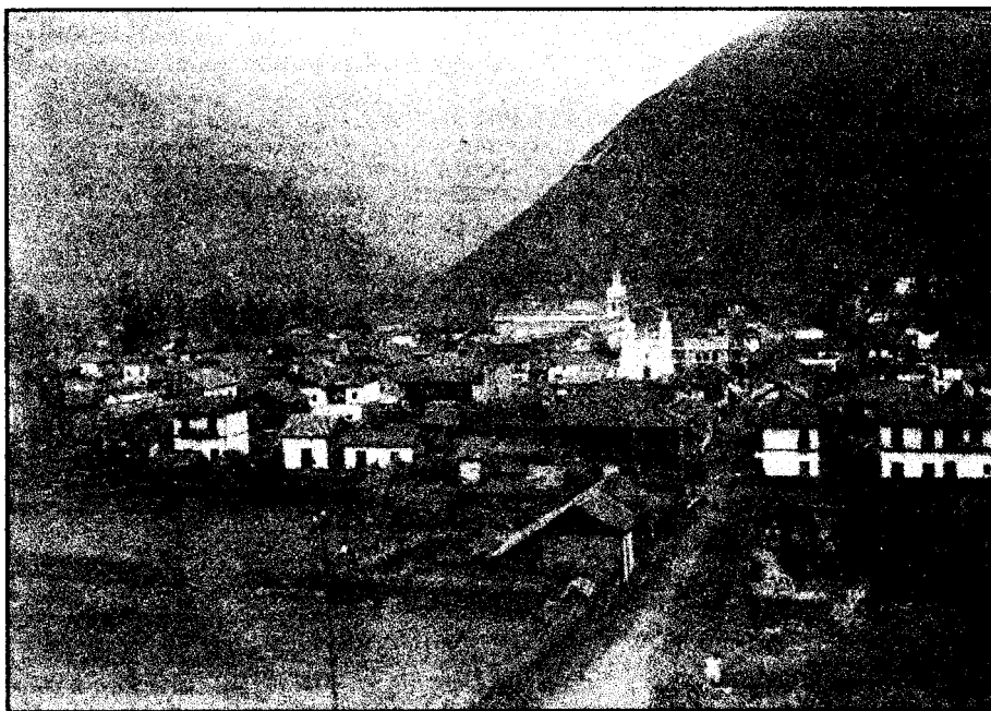
Figura # 2.- La ciudad de Baños tomada desde una loma en 1941 Fuente.- Revista Paisaje, No. 1, Diciembre 1998.
