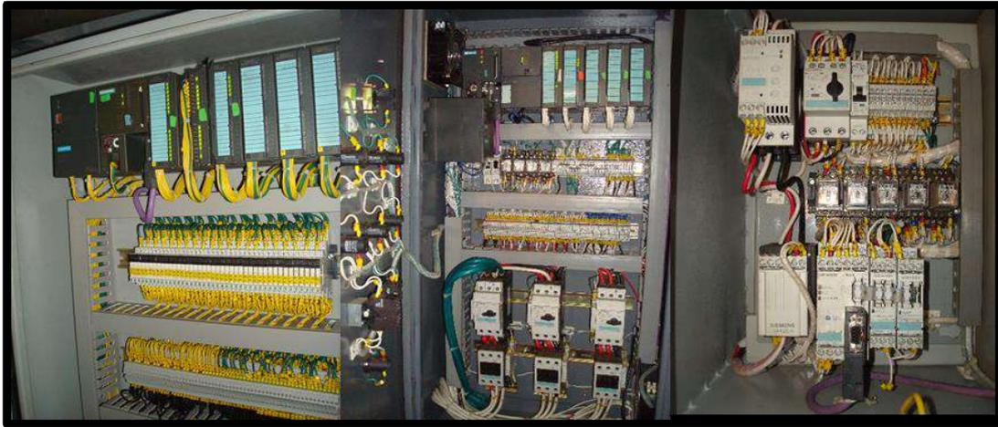
Figura I-6. Cableado Interno de Partidores del CCM
