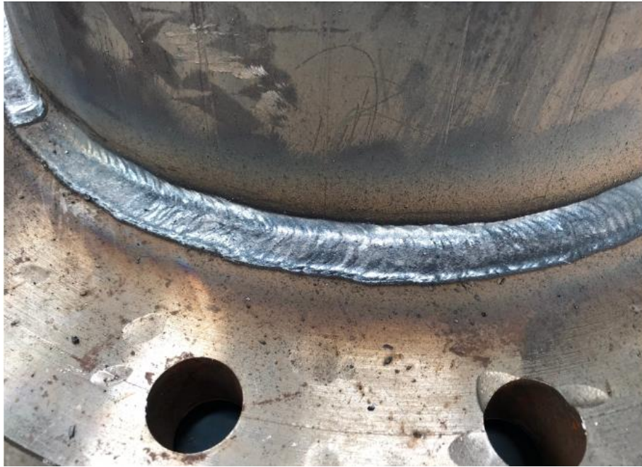
Figura 3. 27. Cordón resultante para la unión de la brida
