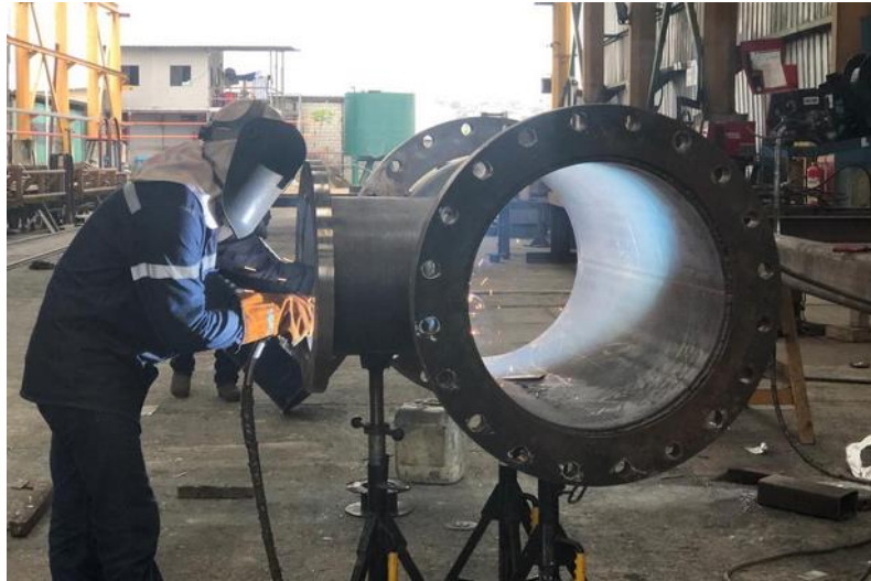
Figura 2. 25. Soldadura de bridas en FIVAR S.A.
