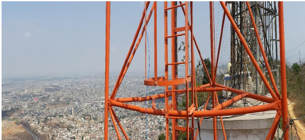
Anexo B. 6 Vista panorámica desde la caseta B39
