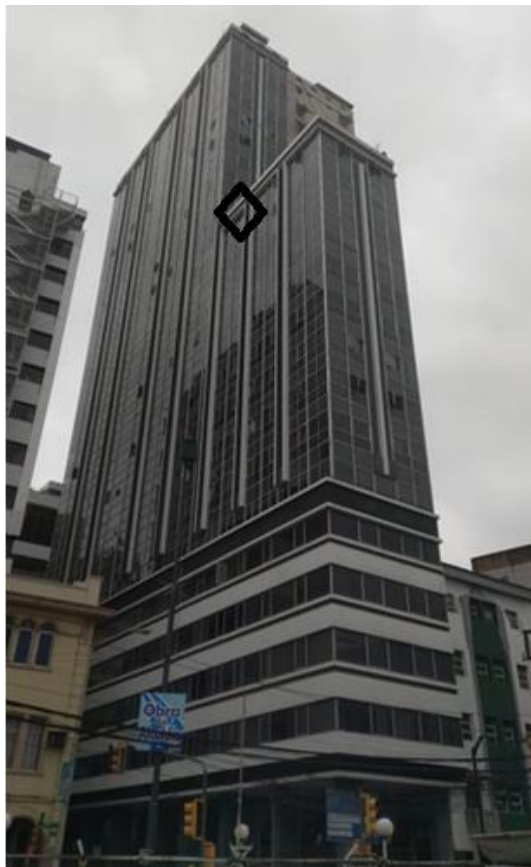
Figura. 3.3. Vista exterior del edificio. ♦ Piso 16
