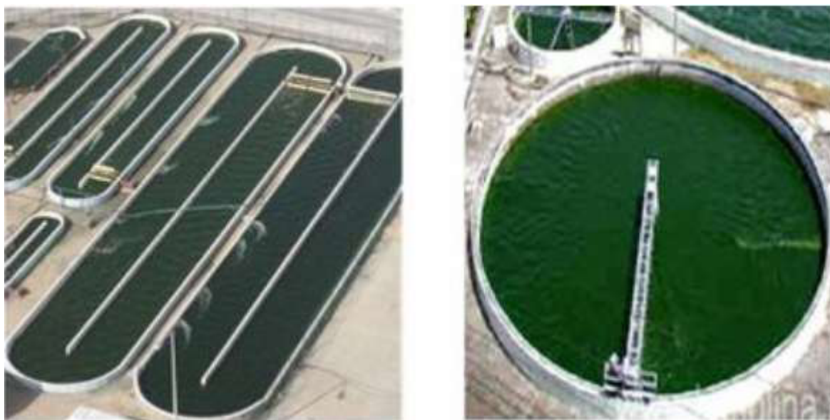
Ilustración 1.5 Sistemas de cultivo de microalgas. A la izquierda un raceway, a la derecha un estanque circular (Klinthong et al., 2015)
