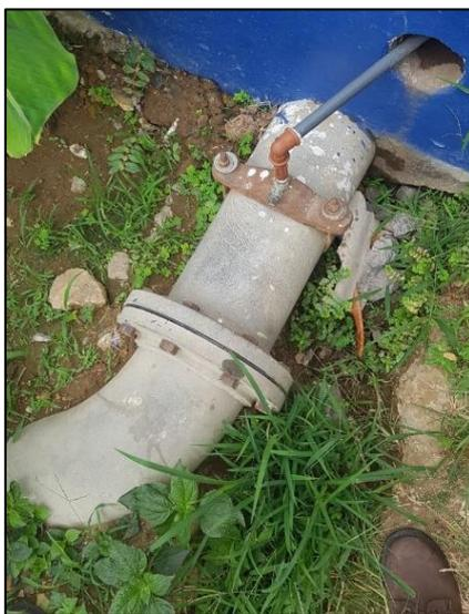
**Ilustración 2.22** Tubería de ingreso (aducción) a la Estación de Bombeo, sector N72-382
