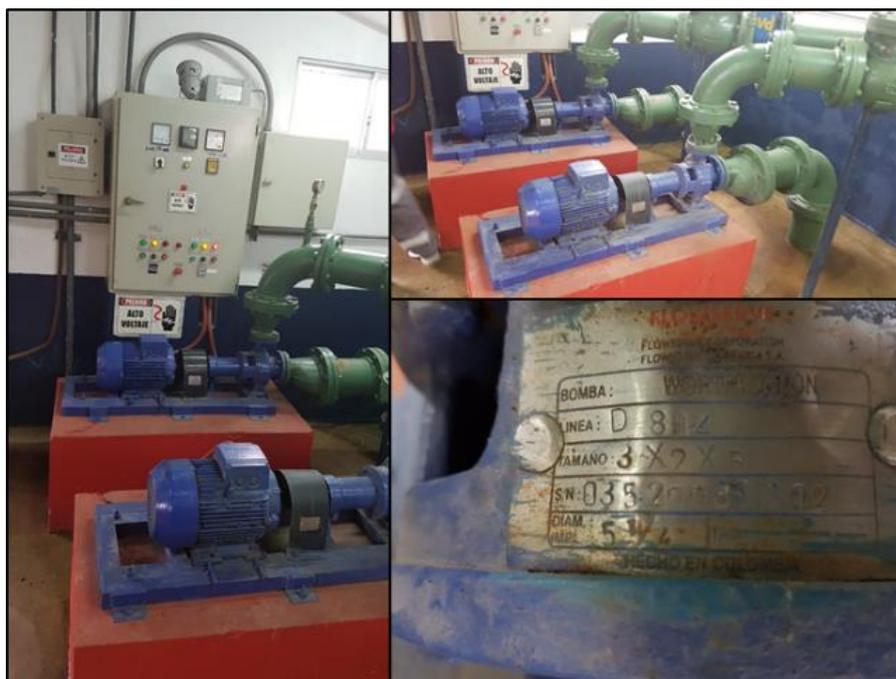
**Ilustración 2.24** Imágenes del equipo de bombas instaladas y placa de características.
