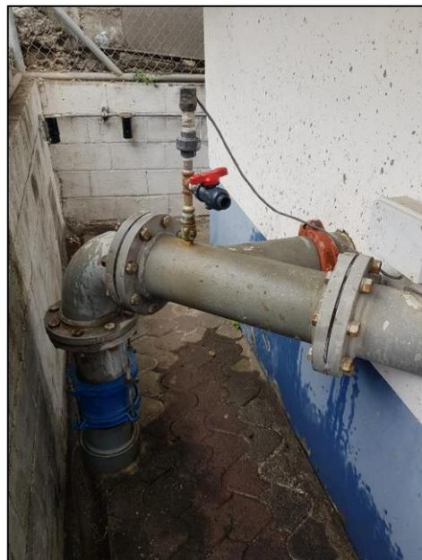
**Ilustración 2.20** Tuberías de salida  $d=200\text{mm}$  de la estación de bombeo, sector N72-382
