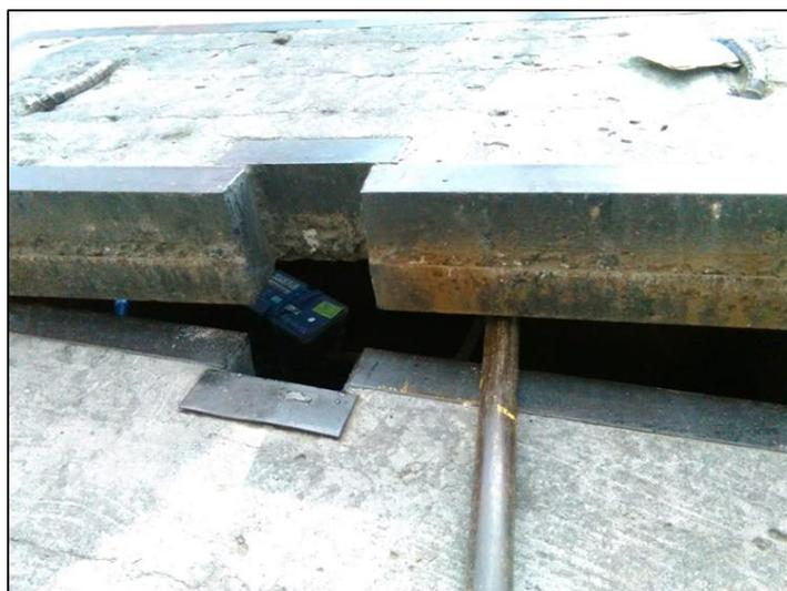
**Ilustración 2.14** Colocación de tapa y equipo de medición
