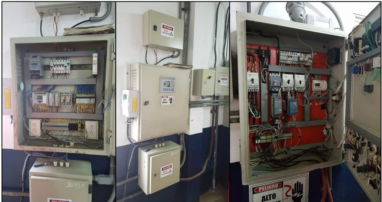
**Ilustración 2.9** Instalaciones eléctricas y de automatización en la estación de bombeo Voluntad de Dios.
