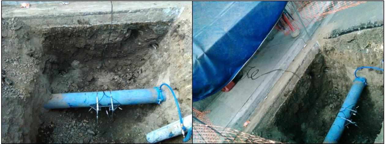
**Ilustración 2.11** Instalación del caudalímetro y datalogger .
