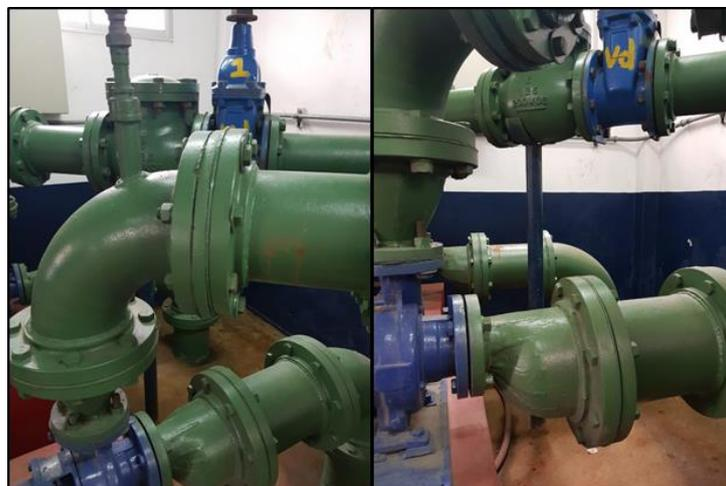
**Ilustración 2.25** Tuberías y accesorios de ingreso y salida del equipo de bombeo existente
