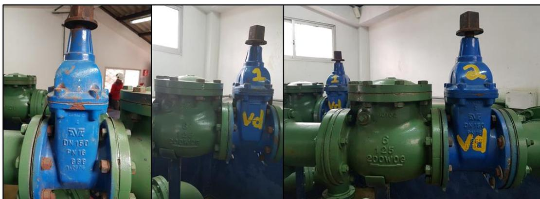
**Ilustración 2.26** Accesorios de salida para medición, control y prevención.
