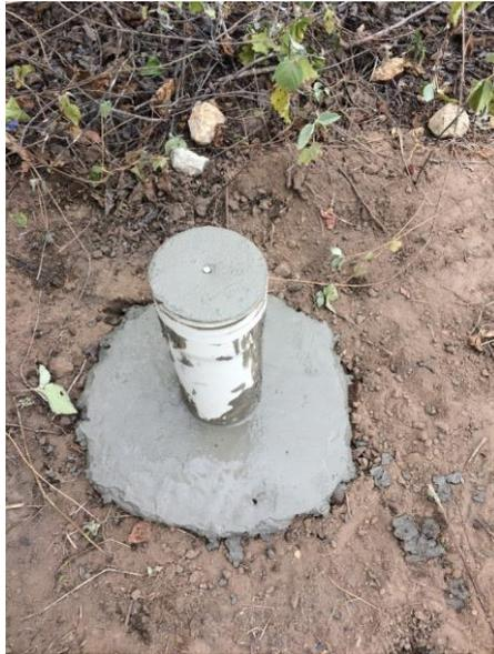
**Figura 2.3** Construcción de hito (punto de control) en zona de estudio.
