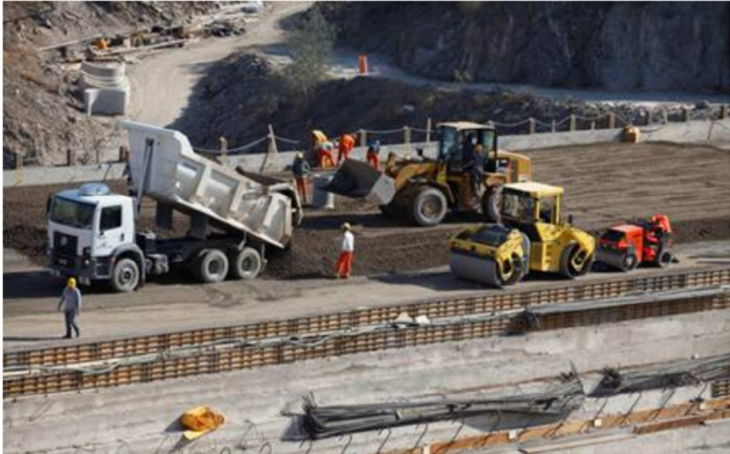
Figura 1 Transporte, colocación y compactación del HCR
