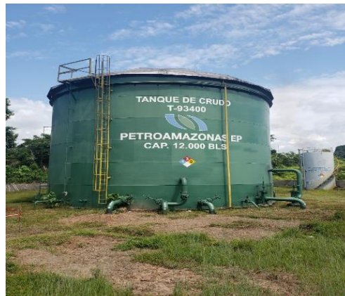
Figura 1.10 Tanque de surgencia
