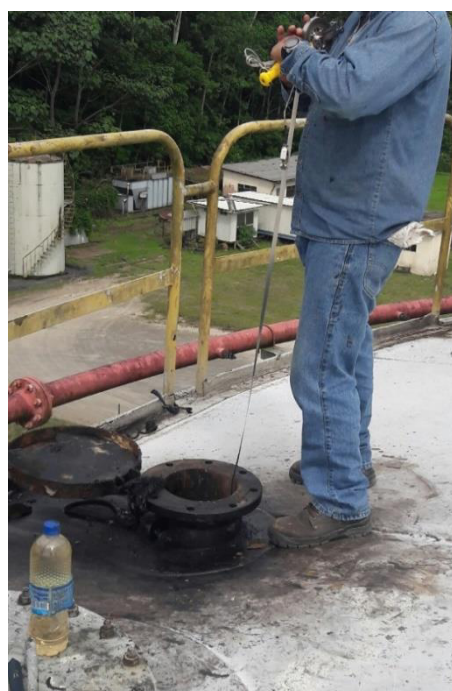
Figura 3.12 Prueba directa de medición de nivel en el Tanque T-620 (PETROAMAZONAS EP, 2019)
